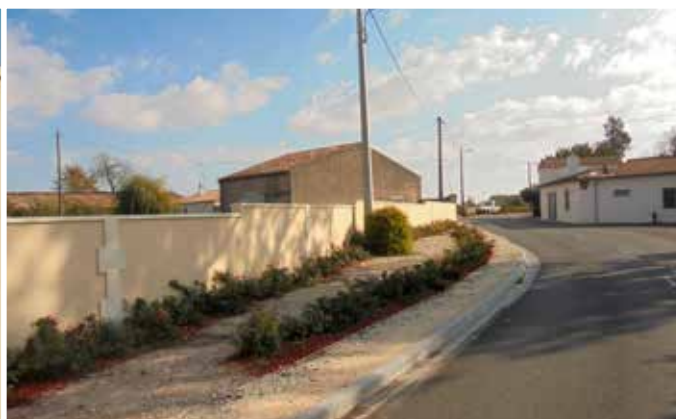
Rénovation du mur de Bel-Orme
