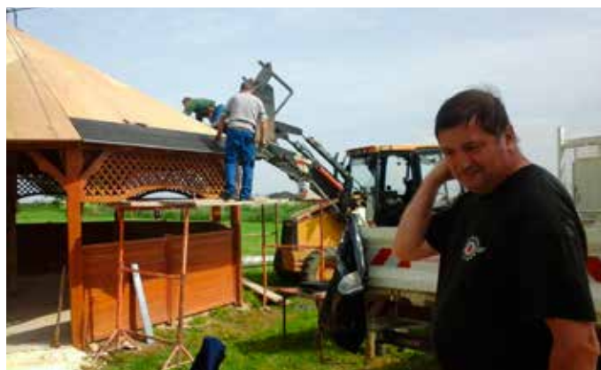
Rénovation du kiosque de la Maréchale
