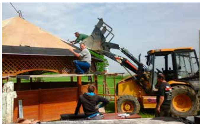
Rénovation du kiosque de la Maréchale
