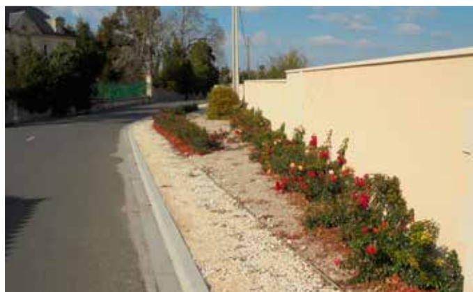
Rénovation du mur de Bel-Orme
