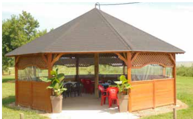
Rénovation du kiosque de la Maréchale
